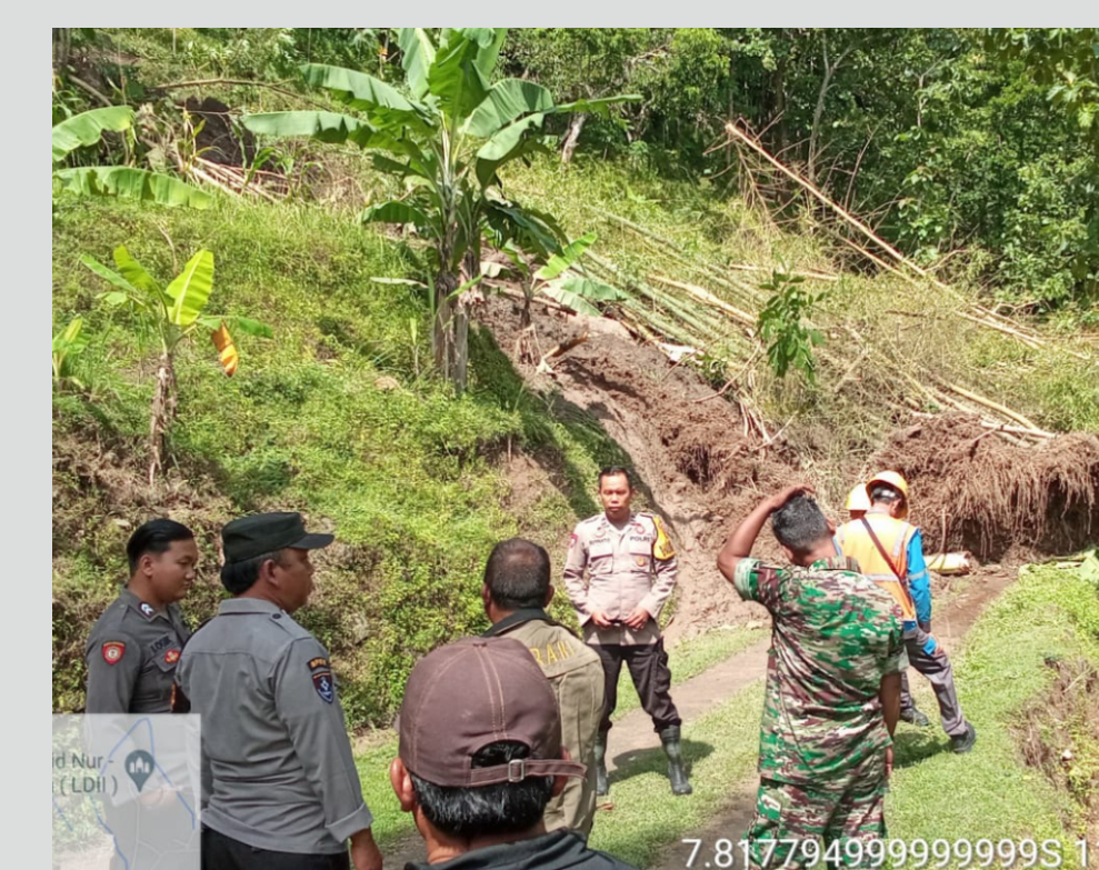
Tanah Longsor | 28-03-24 | Gedangsari Kab. Gunungkidul F. Relawan Kab. Gunungkidul
